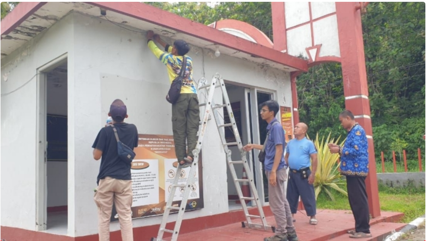
Pemasangan CCTV,DVR,dan NVR Oleh Petugas
